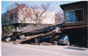
▲地震による家屋の倒壊
